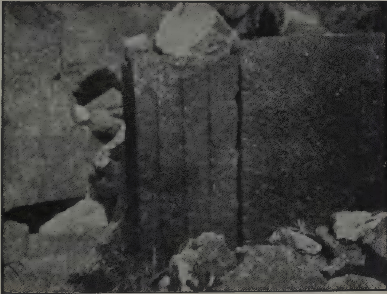
FIG. 78.—No. 11, W. door jamb.
